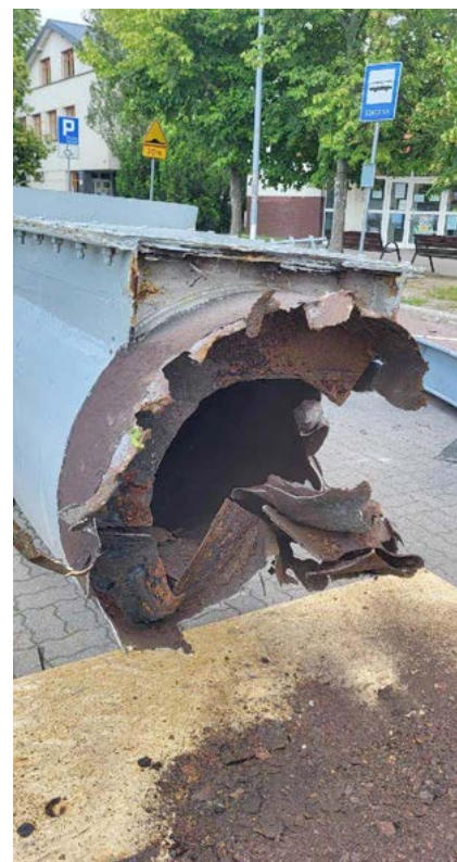
Podstawa komina po zdemontowaniu ostatniej, najniższej sekcji. Jak widać, w ekspertyzie wykonanej na zlecenie urzędu nie było cienia przesady – komin w każdej chwili mógł się zawalić.
