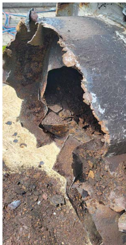
Podstawa komina po zdemontowaniu ostatniej, najniższej sekcji. Jak widać, w ekspertyzie wykonanej na zlecenie urzędu nie było cienia przesady – komin w każdej chwili mógł się zawalić.
