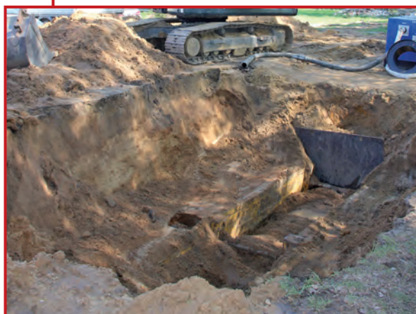
Budowa kanalizacji, fot. J. Kaiper
