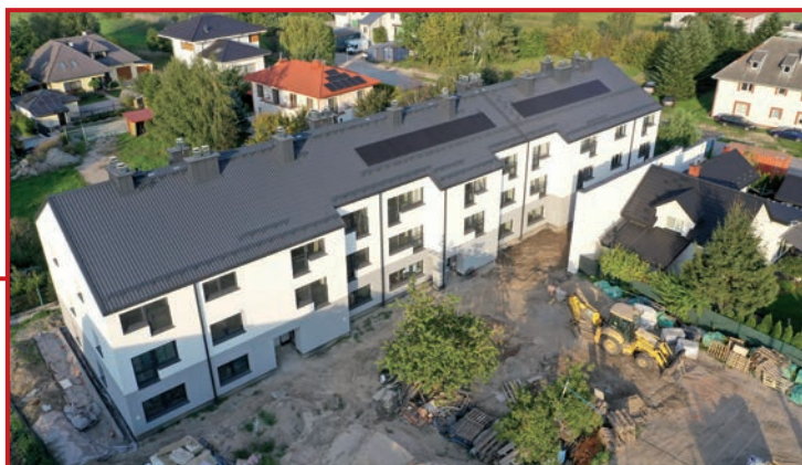
Dom komunalny. Fot. arch. UGR
