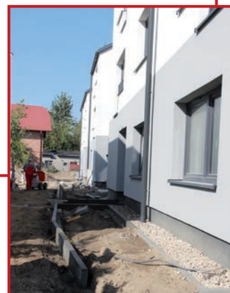
Zakładane są krawężniki. Fot. J.K.
