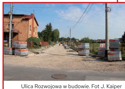
Ulica Rozwojowa w budowie. Fot. J. Kaiper
