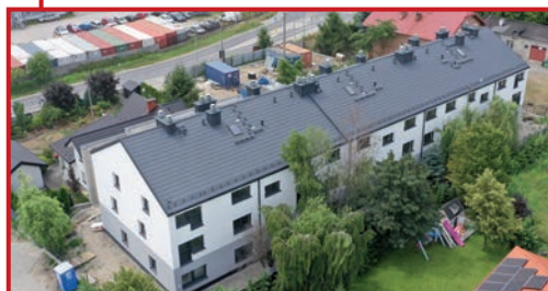
Dom Komunalny. Fot. arch. UG
