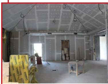
Ocieplanie i prace instalacyjne
