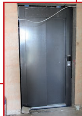
Zainstalowano windy. Fot. J. Kaiper
