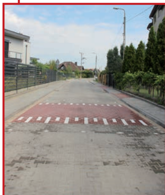
Ulica Dworkowa wybudowana
