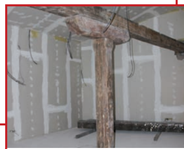
Zabytkowe elementy nośne
