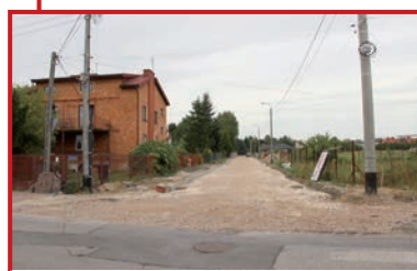
Ul. Rozwojowa w budowie
