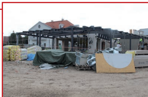
Konstrukcja pawilonu w elewacji ogrodowej
