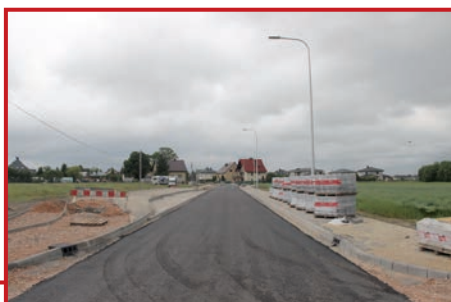
Fragment wybudowanej jezdni
