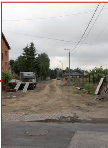
Ulica Rozwojowa w budowie
