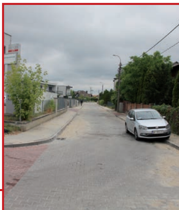
Ulica Dworkowa wybudowana
