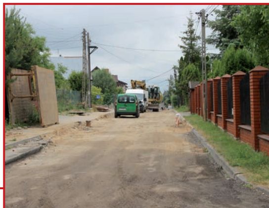
Ulica Dolna w budowie
