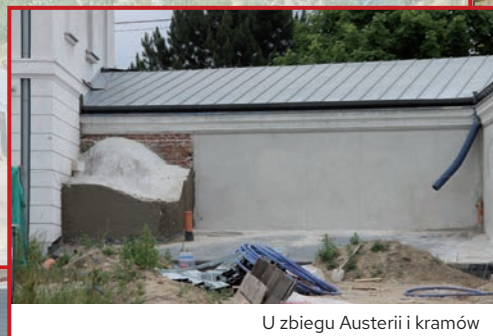
Zakładanie obróbek dachowych
