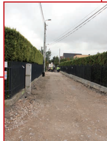
Ulica Zakole w budowie
