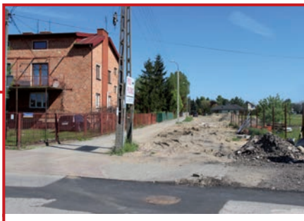
Ulica Rozwojowa w trakcie przebudowy
