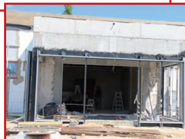
Wejście do żłobka
