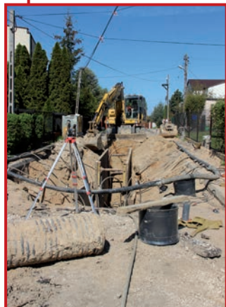
Budowa kanalizacji w ul. Dolnej
