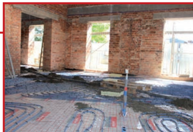
Ogrzewanie podłogowe
