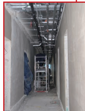
Tynki wewnętrzne
