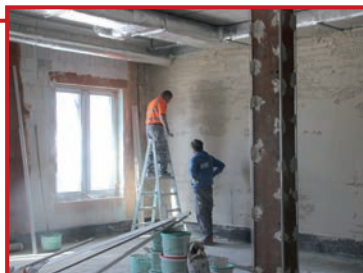
Tynkowanie wnętrza
