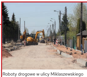
Roboty drogowe w ulicy Miklaszewskiego
