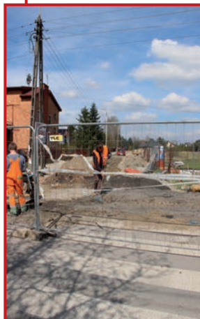
Instalacje w ulicy Rozwojowej
