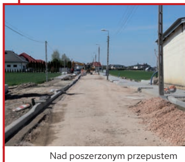
Nad poszerzonym przepustem
