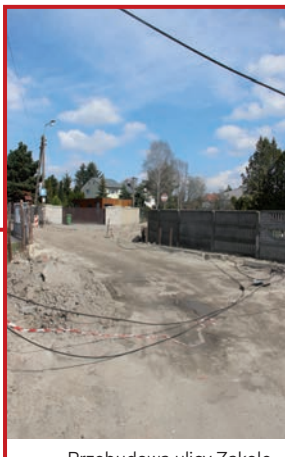
Przebudowa ulicy Zakole (od Raszyńskiej)
