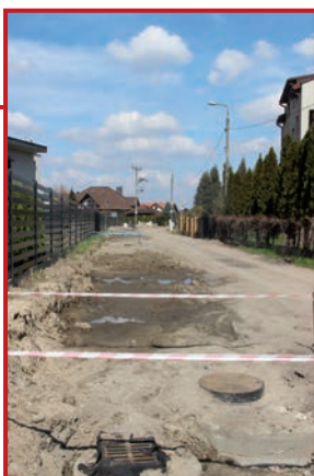
Ulica Dworkowa budowana od podstaw
