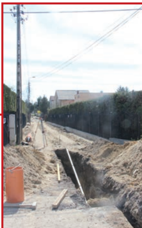
Kanalizacja w ulicy Zakole
