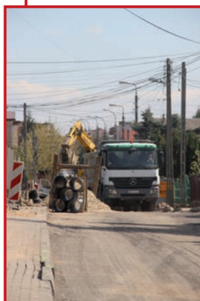
PRZEBUDOWA 5 ULIC – POLSKI ŁĄD
