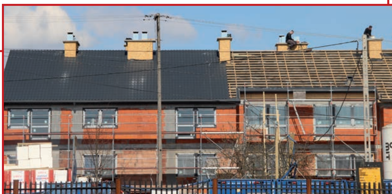
Montaż dachu na domu komunalnym
