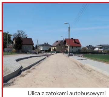
Ulica z zatokami autobusowymi
