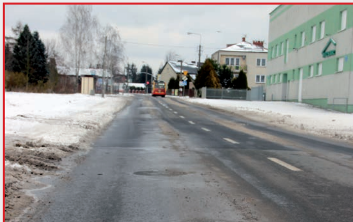
Kanalizacja w ul. Długiej
