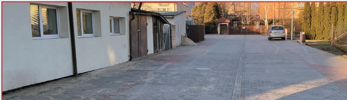
Ulica Szczygła po przebudowie
