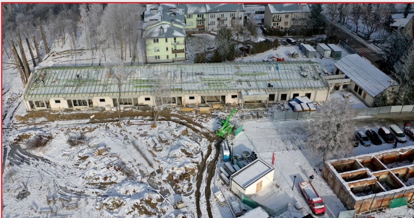
Budowa gminnego żłobka. Fot. arch. gminy
