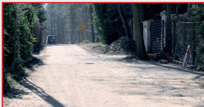
Kanalizacja w ulicy Jeża
