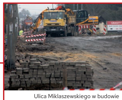
Krawężniki na Miklaszewskiego
