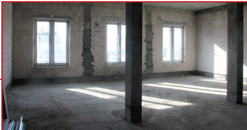
Przyszła sala żłobka
