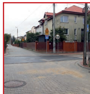
Ulica Łąkowa po przebudowie
