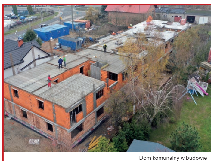
Dom komunalny w budowie
