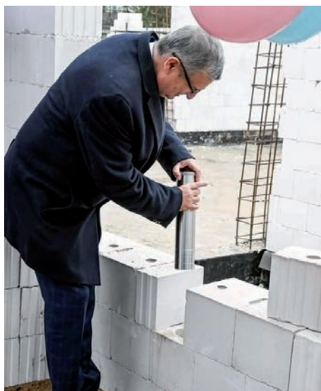
Wójt Andrzej Zaręba wmurowuje akt erekcyjny. Fot. arch. UGR
