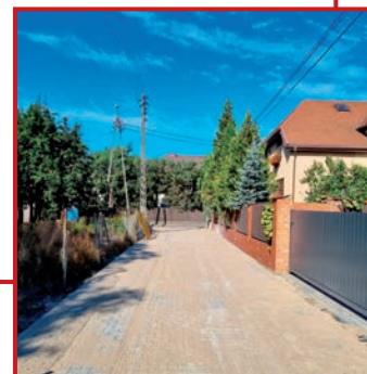
Ulica Wąska odnowiona
