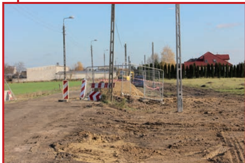
Nowe słupy energetyczne na poszerzonej ulicy
