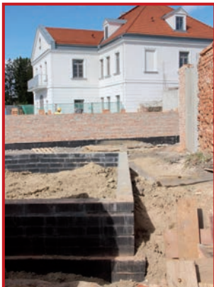
Budowa na tle Austerii
