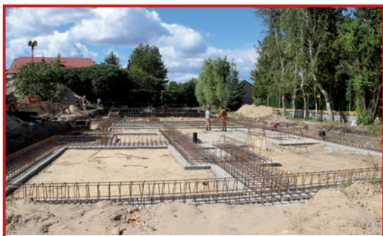
Prace budowlane rozpoczęto
