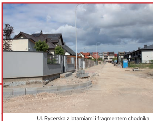
Ul. Poziomkowa z kanalizacją deszczową
