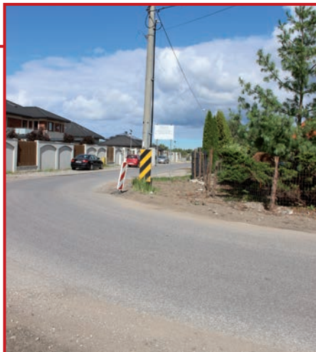
Miejsce na chodnik na zakręcie
