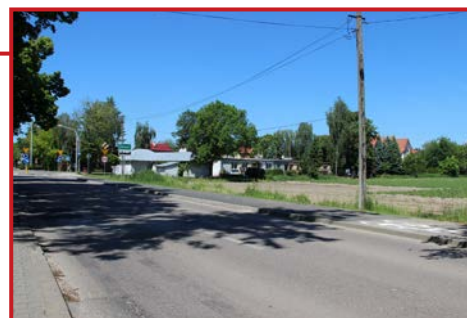
Wybudowana ścieżka w ulicy Raszyńskiej
