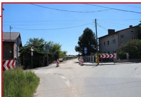
Budowana ścieżka w ulicy Górnej
