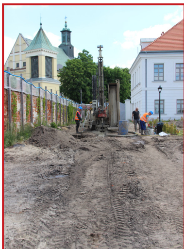
Wiercenia pod pompę ciepła
