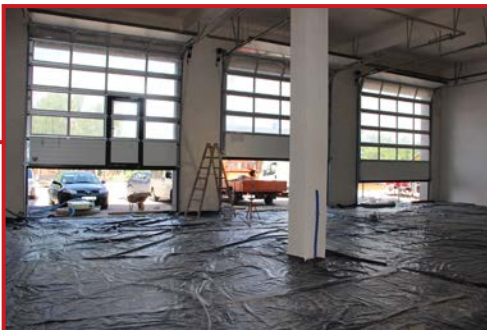
Izolacja podłogi garażu
