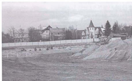
Budowa basenu. Fot. arch. CSR
