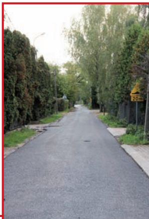
Ulica Poniatowskiego z pierwszą warstwą asfaltu. © J. Kaiper
