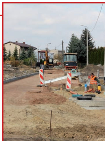
Budowa przepompowni. © J. Kaiper
