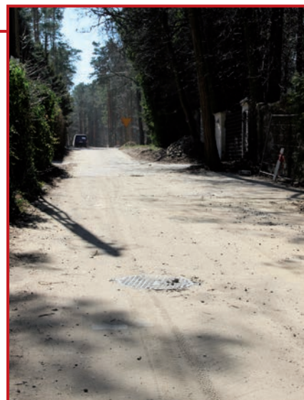
Kanalizacja w ulicy Jeża. Fot. J. Kaiper
