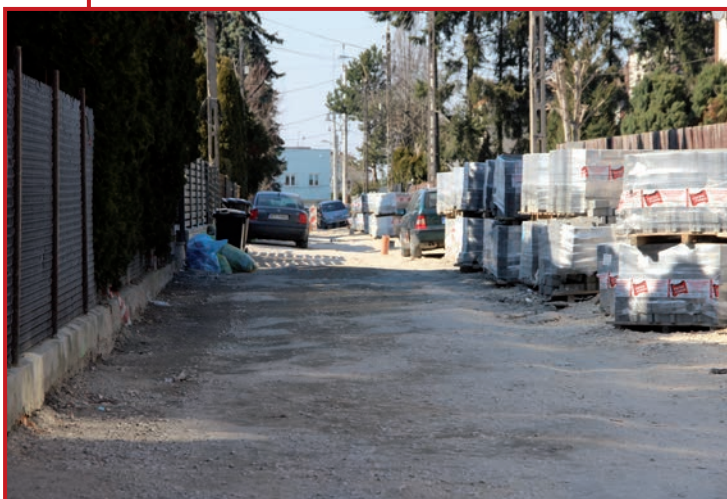
Ulica Prosta przed ułożeniem nawierzchni. Fot. J. Kaiper
