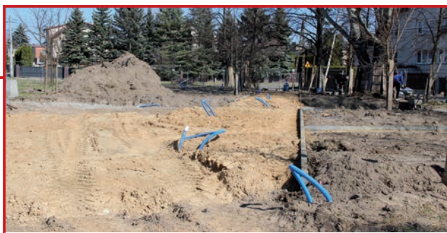
Powstaje główny ciąg pieszy.
