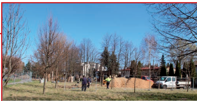
Ogradzanie placu budowy.
