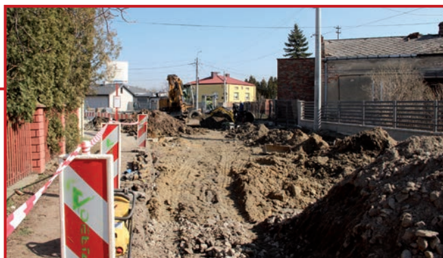
Rondo w przebudowie.
