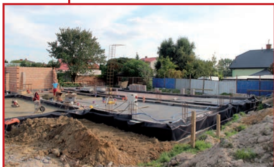
Strażnica OSP Dawidy w budowie.
