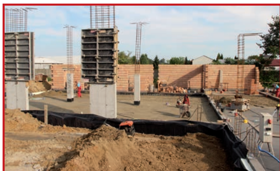
Hala samochodowa w budowie.
