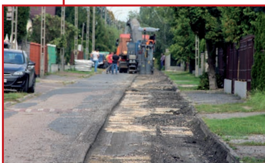
Ulica Cicha ruszyła przebudowa.
