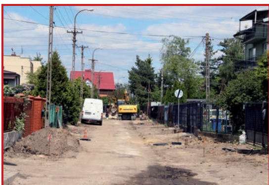
Przebudowa ulicy Waryńskiego.
