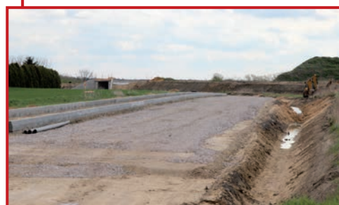
Na S7 powstają nowe drogi dojazdowe.
