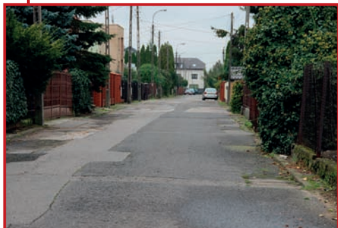
Ul. Akacjowa stan sprzed przebudowy. Fot. J. Kaiper
