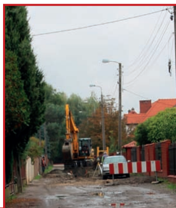
Maszyny wjechały już na plac budowy. Fot. J. Kaiper
