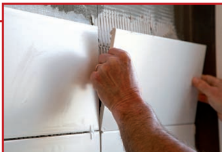
Remont łazienek w SP w Raszynie.
