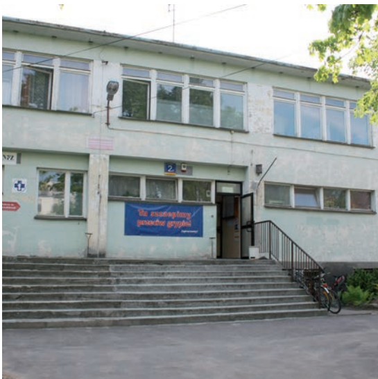
Ośrodek zdrowia przed remontem
